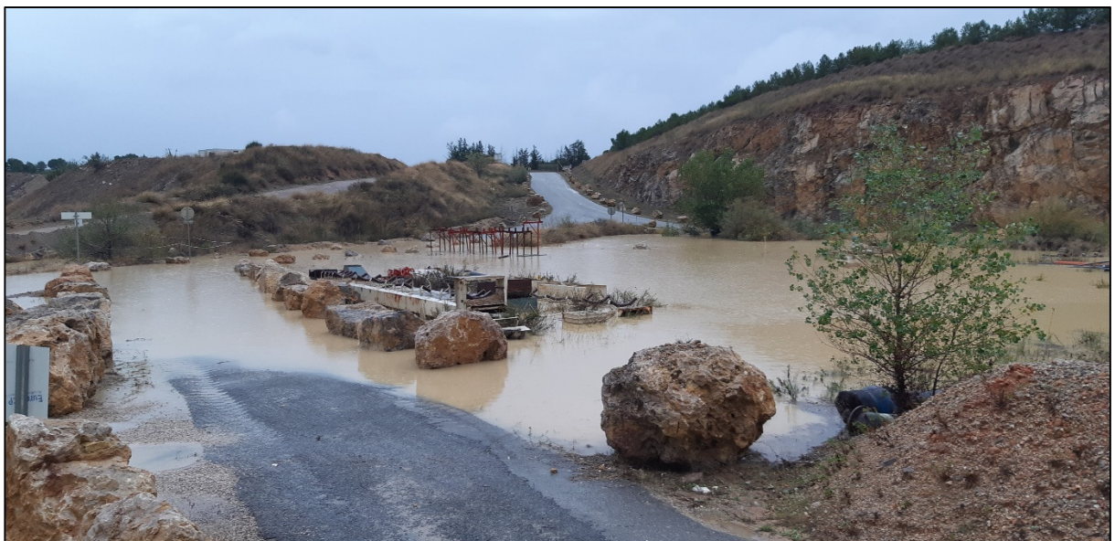
Figure 10. Inondation du fond de la carrière – 23/10/2019
