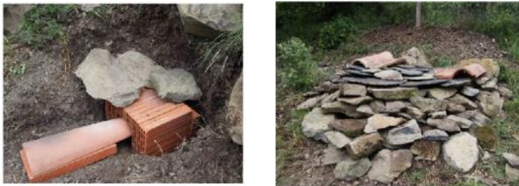
Figure 12 : exemple d'un abri profond (brique) avec son accès ; à nu puis recouvert de pierres
