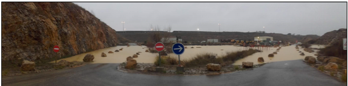
Figure 9. Inondation du fond de la carrière – 01/03/2018
