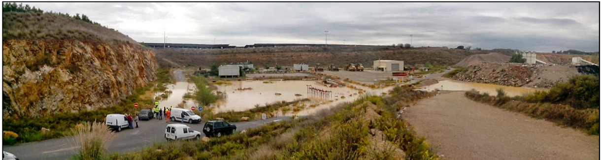
Figure 8. Inondation du fond de la carrière – 30/09/2014
